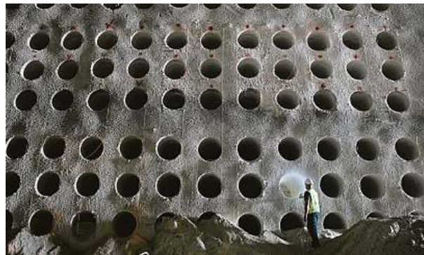
Stav výstavby hřbitova před dvěma lety
