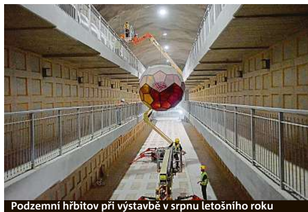
Podzemní hřbitov při výstavbě v srpnu letošního roku
