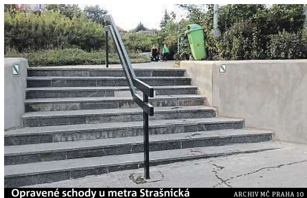
Opravené schody u metra Strašnická
