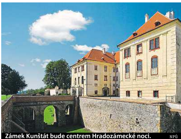
Zámek Kunštát bude centrem Hradozámecké noci.
