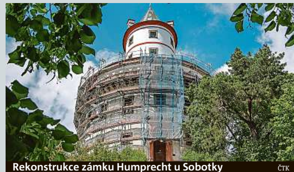
Rekonstrukce zámku Humprecht u Sobotky ČTK
