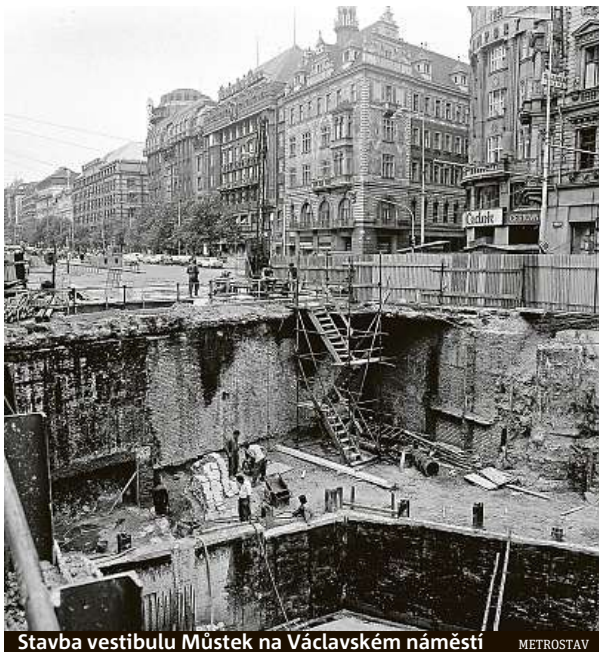
Stavba vestibulu Můstek na Václavském náměstí
