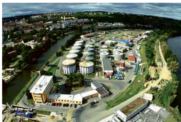
Ústřední čistírna odpadních vod (ÚČOV) v Praze na Císařském ostrově.
