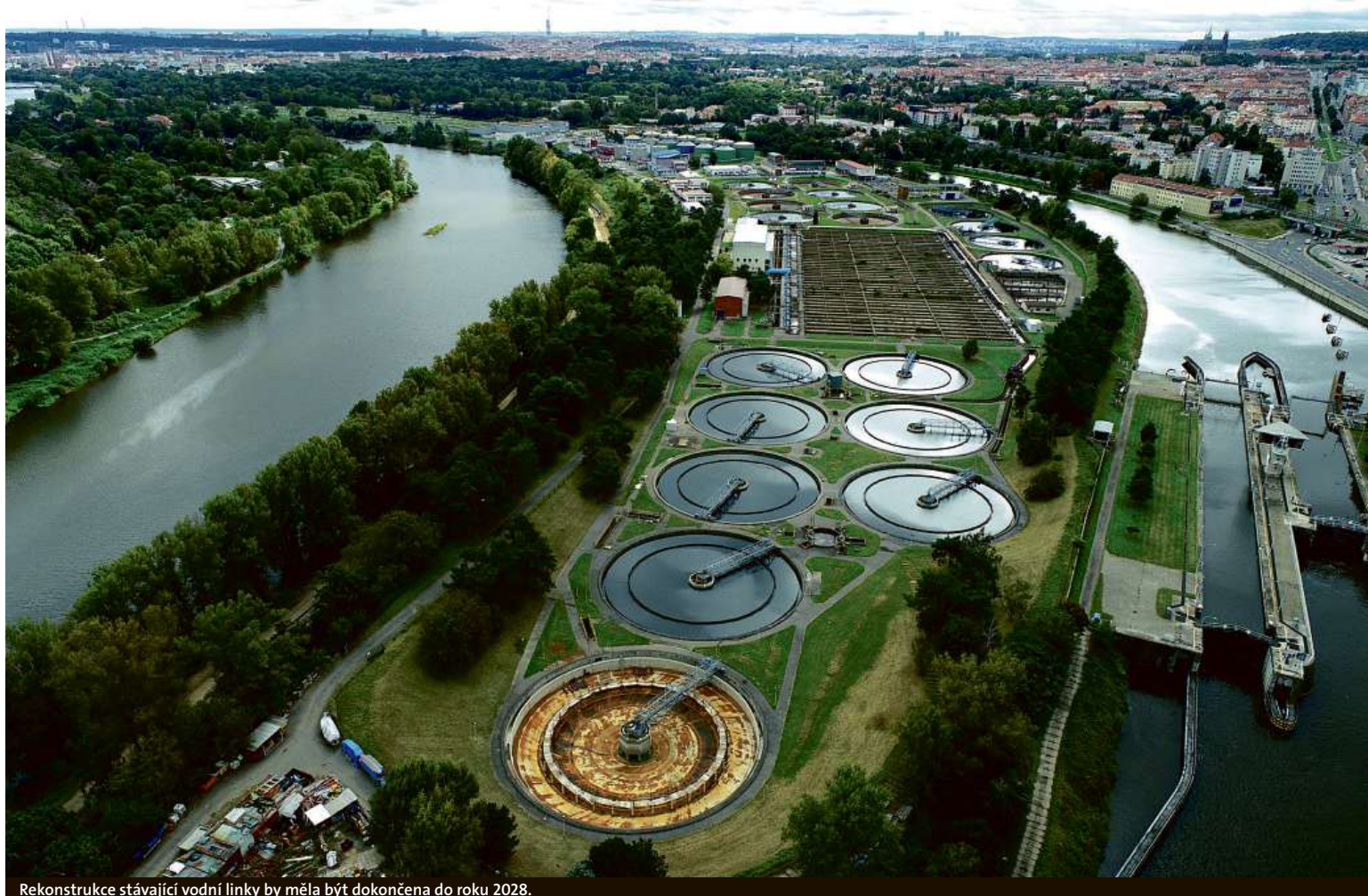
Rekonstrukce stávající vodní linky by měla být dokončena do roku 2028.
