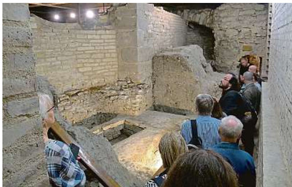
Základy Břevnovského kláštera
