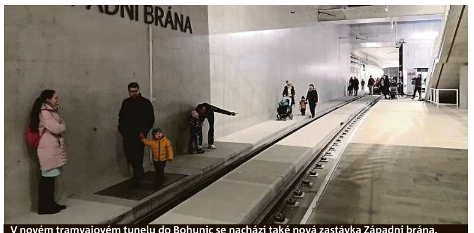
V novém tramvajovém tunelu do Bohunic se nachází také nová zastávka Západní brána.
