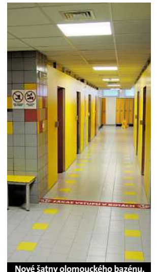
Nové šatny olomouckého bazénu.
