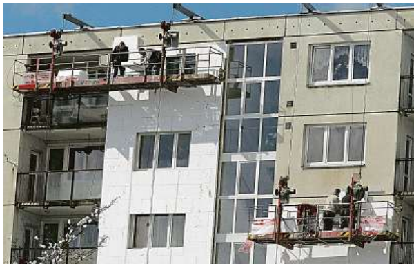
Většina panelových domů v Česku už prošla zateplením. I tak se ale jen výjimečně dostanou do energetické kategorie C.
