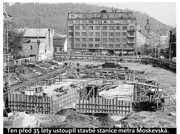
Ten před 35 lety ustoupil stavbě stanice metra Moskevská.
