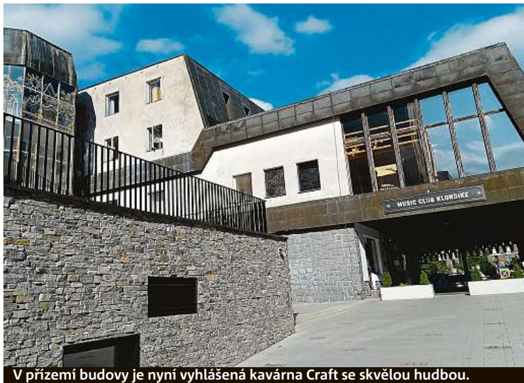
V přízemí budovy je nyní vyhlášena kavárna Craft se skvělou hudbou.
