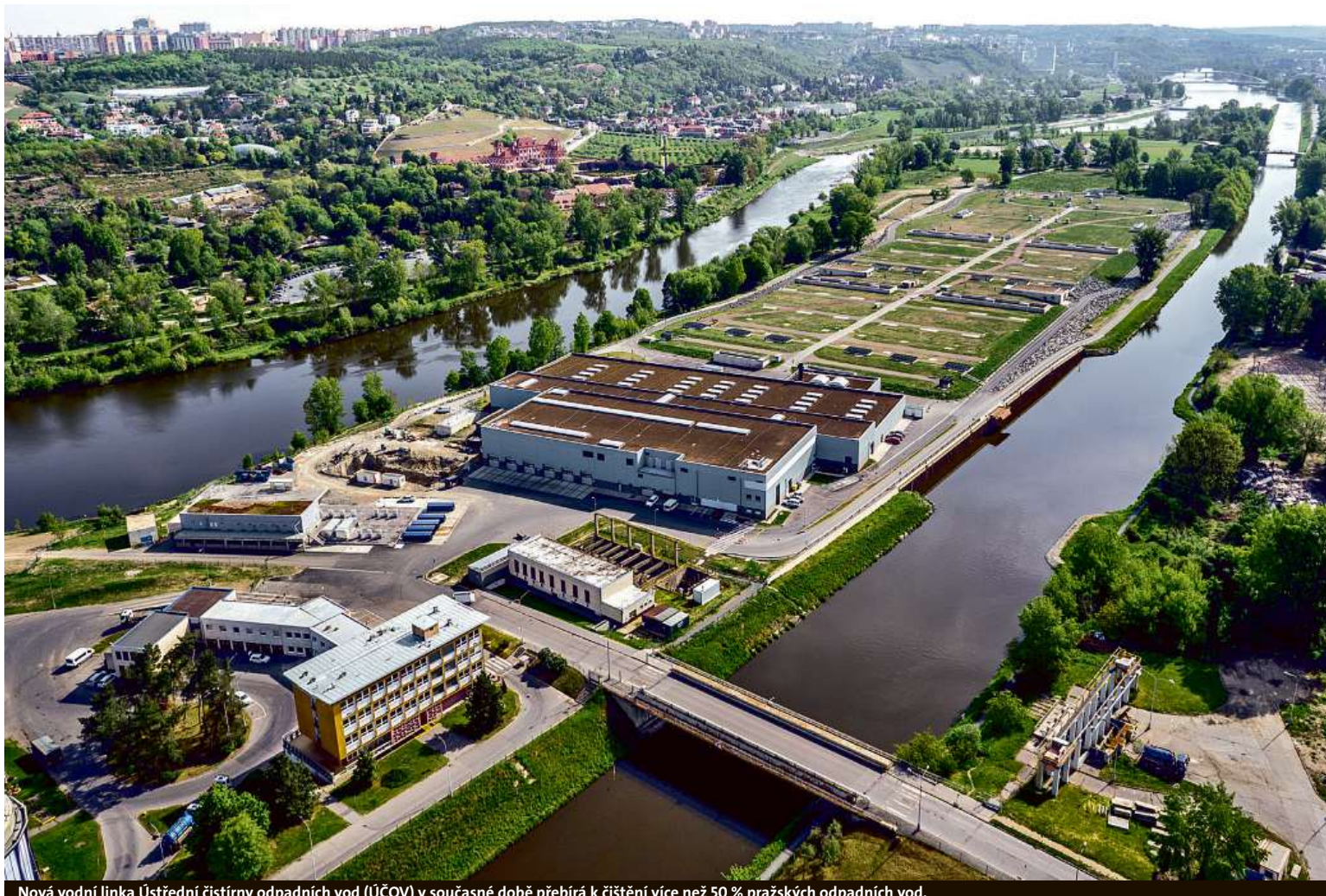
Nová vodní linka Ústřední čistírny odpadních vod (ÚČOV) v současné době přebírá k čištění více než 50 % pražských odpadních vod.
