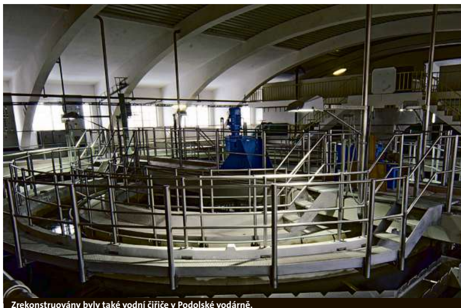
Zrekonstruovány byly také vodní čičče v Podolské vodárně.
