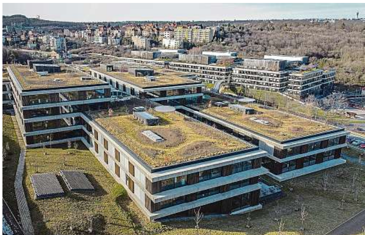
ČSOB soustředila všechny hlavní činnosti a rozdrobené kanceláře z centra Prahy až „daleko“ na levý břeh Vltavy do Radlic, do energeticky úsporných budov. MAFRA
