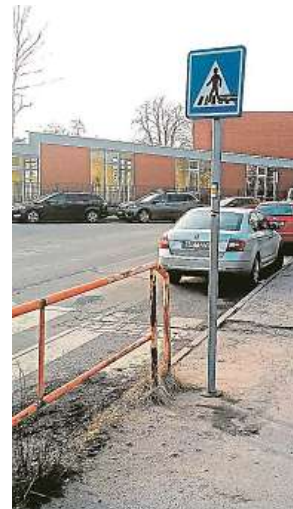
Před a po úklidu TOMÁŠ H. a PS
