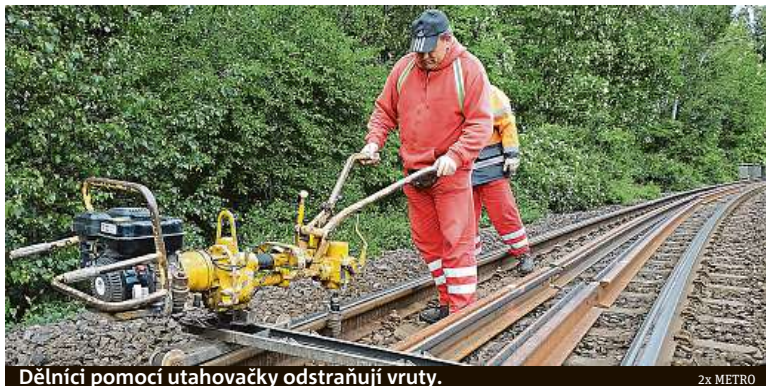
Dělníci pomocí utahovačky odstraňují vruty.
