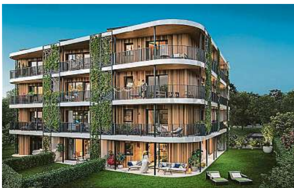
Požární předpisy dovolují v Česku stavět domy ze dřeva do 12 metrů. Dům v Řeporyjích bude čtyřpodlažní a výšku dodrží. UBM DEVELOPMENT
