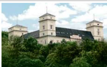
Zámek Račice, přestavba
