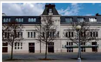
Multifunkční budova, Brno
