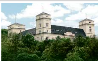
Zámek Račice, přestavba
