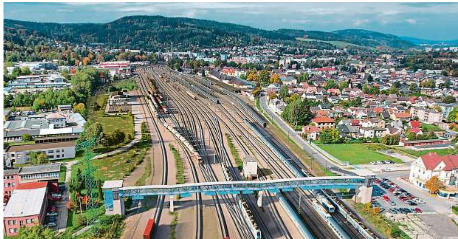
V příštím roce se rozběhne rekonstrukce stanice Česká Třebová.
