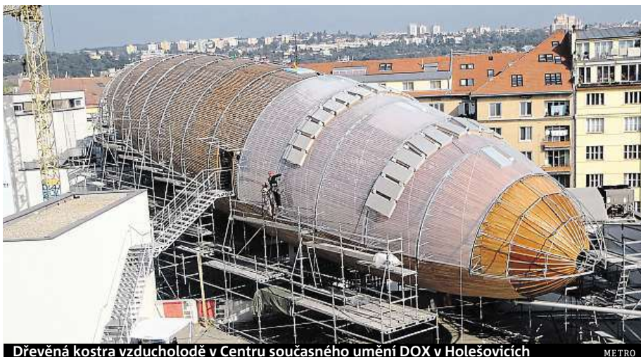
Dřevěná kostra vzducholodě v Centru současného umění DOX v Holešovicích
