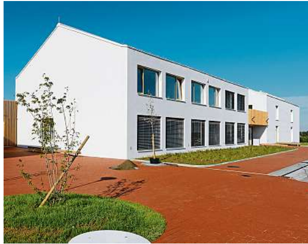
Základní škola v Psářech u Prahy. Budova pro 540 žáků je pasivním domem, který má velmi nízkou spotřebu energie na vytápění. MAFRA
