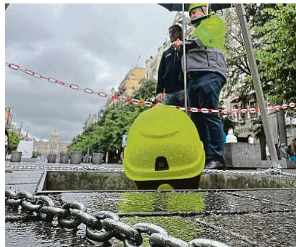
Vodní prvek, respektive jeho technické zázemí, zasahuje dva metry pod zem. Každý rok se musí čistit, což je údajně dřina. 2x THMP
