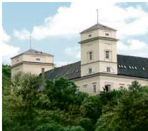
Zámek Račice, přestavba
