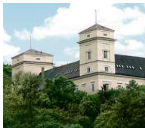
Zámek Račice, přestavba
