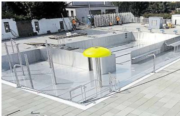
Dělníci na Pražačce doladují poslední detaily. FB PRAŽAČKA
