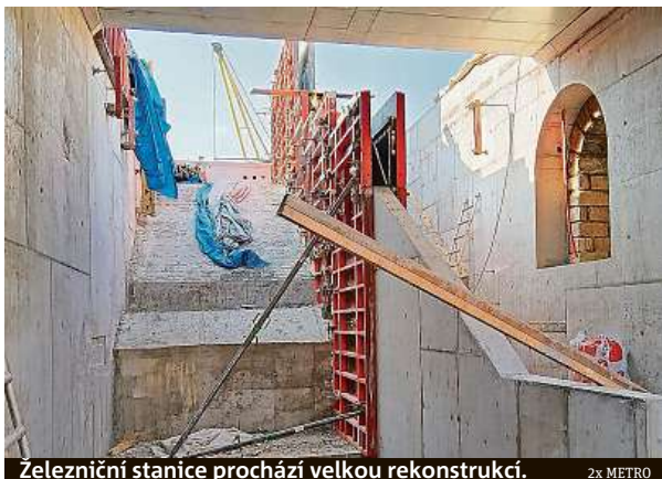
Železniční stanice prochází velkou rekonstrukcí. 2x METRO
