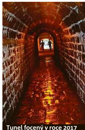
Tunel focený v roce 2017
