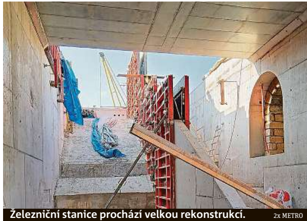
Železniční stanice prochází velkou rekonstrukcí. 2x METRO
