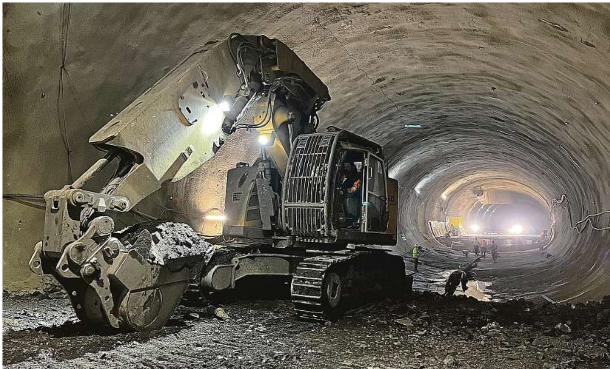
Zhruba v těchto místech vzniknou obrátové koleje pro metro. Ve tmě v dálce bude zase stanice Pankrác.
