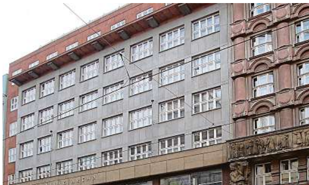
Z dočasného sídla na Žižkově se v loňském roce ústav přestěhoval do centra Prahy do Paláce Archa v ulici Na Poříčí. WIKIMEDIA COMMONS
