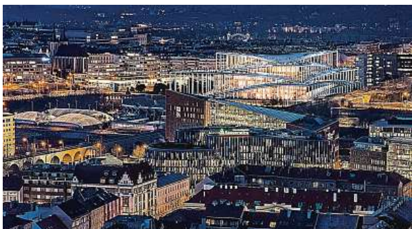
Vltavská filharmonie je budoucí kulturní centrum České republiky a dominanta hlavního města Prahy. 5x BIG BJARKE INGELS GROUP
