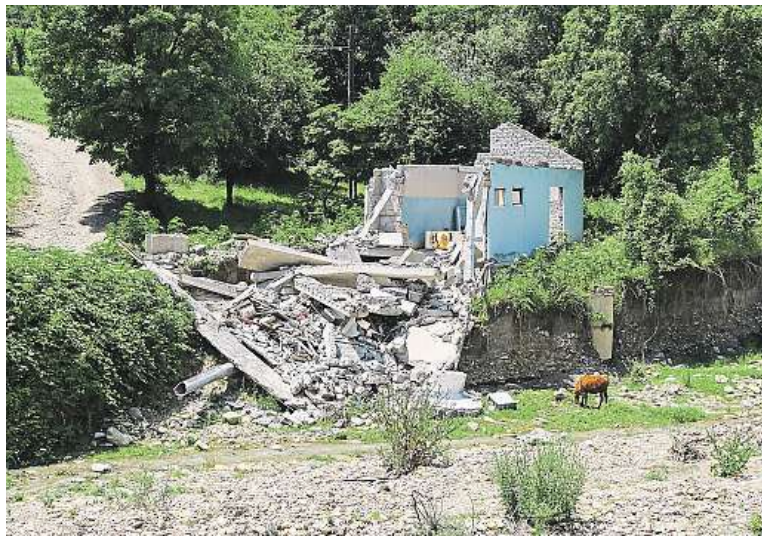
Takto může s domem zacvičit říční březní eroze.
