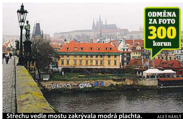
Střechu vedle mostu zakrývala modrá plachta.
