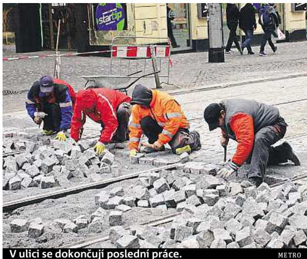
V ulici se dokončují poslední práce. METRO
