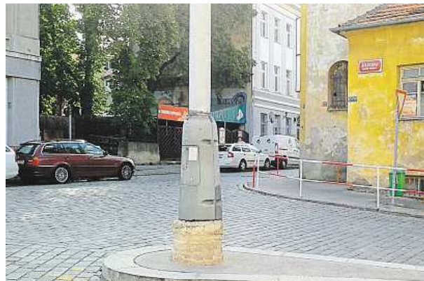
Sloup veřejného osvětlení je prý nyní lépe chráněn. MAFRA
