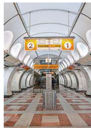
Architekturu středové lodi znehodnotil v roce 2014 výtah.
