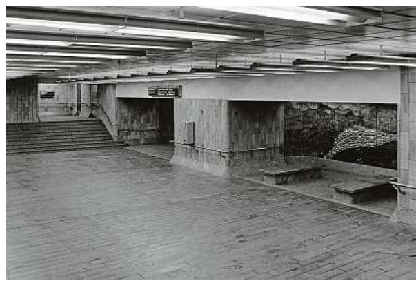
Stanice Smíchovské nádraží v roce 1985. Fotograf zachytil část jižního vestibulu, kde byly dříve umístěny výklenky s lavičkami a uměním.
