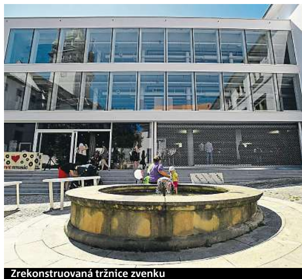
Zrekonstruovaná tržnice zvenku
