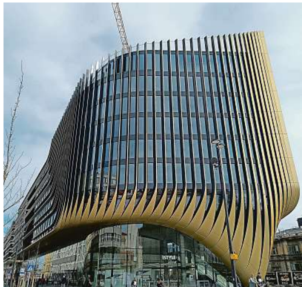
V případě Masaryčky vznikla budova z pera světově proslulých architektů z ateliéru Zahy Hadid.
