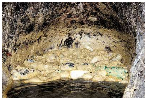
Oleje ztuhnou, zanášejí kanalizaci a mohou způsobit ucpání.
