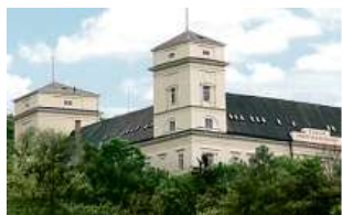
Zámek Račice, přestavba
