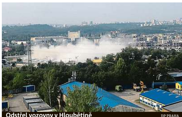
Odstřel vozovny v Hloubětíně
