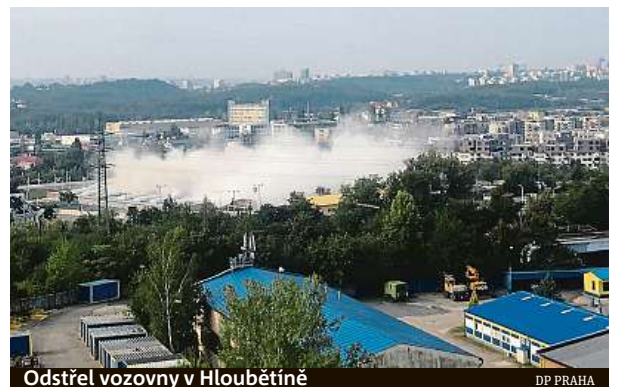
Odstřel vozovny v Hloubětíně DP PRAHA
