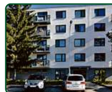
Rezidence Pěkná, Brno, nebytové prostory
