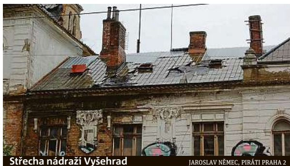
Střecha nádraží Vyšehrad
