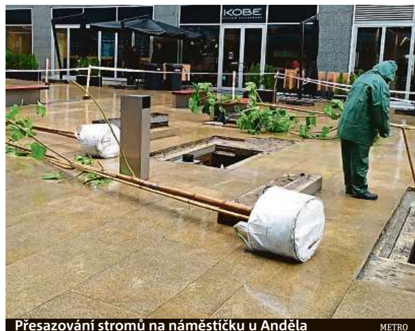
Přesazování stromů na náměstíčku u Anděla
