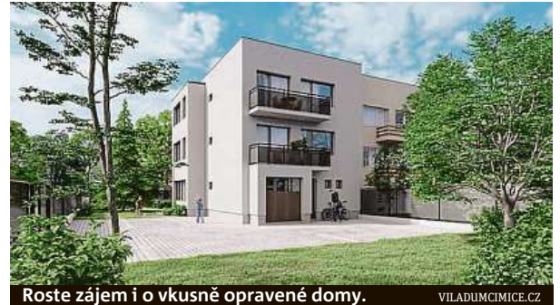
Roste zájem i o vkusně opravené domy.
