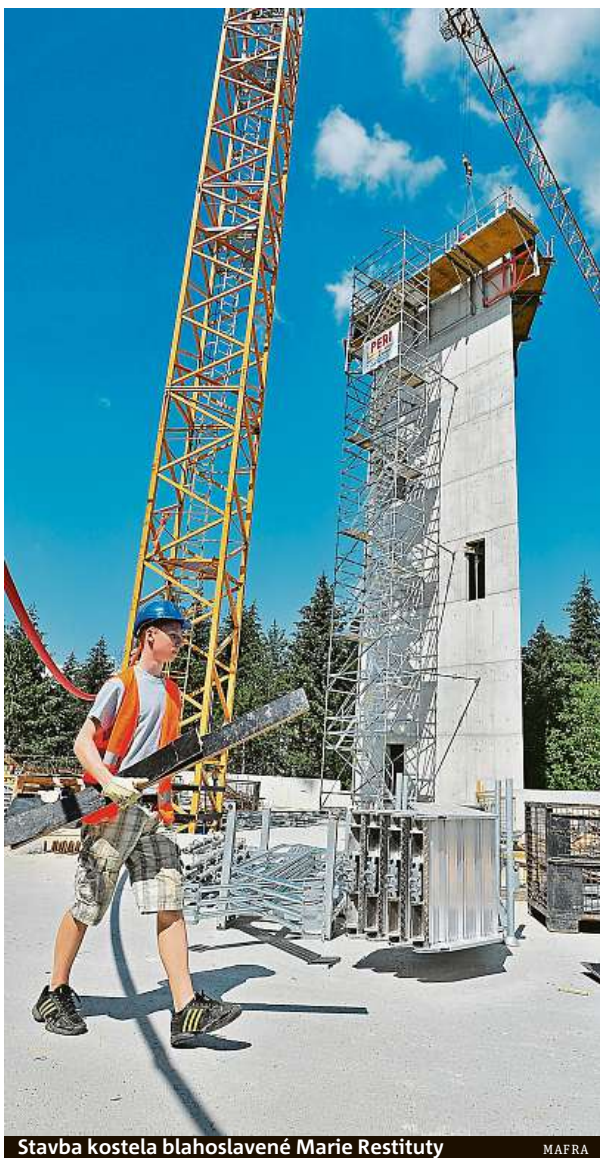
Stavba kostela blahoslavené Marie Restituty
