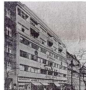
Dům ve Štěpánské v původní Havlíčkově podobě ČS ARCHITEKT
