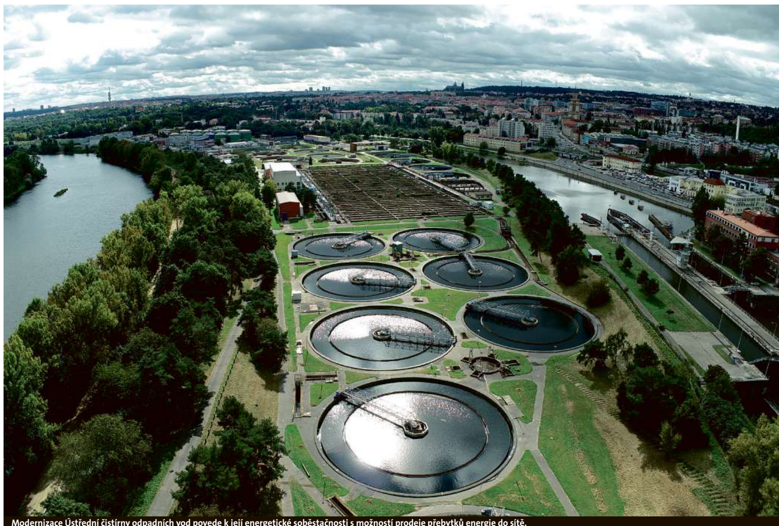
Modernizace Ústřední čistírny odpadních vod povede k její energetické soběstačnosti s možností prodeje přebytků energie do sítě.
