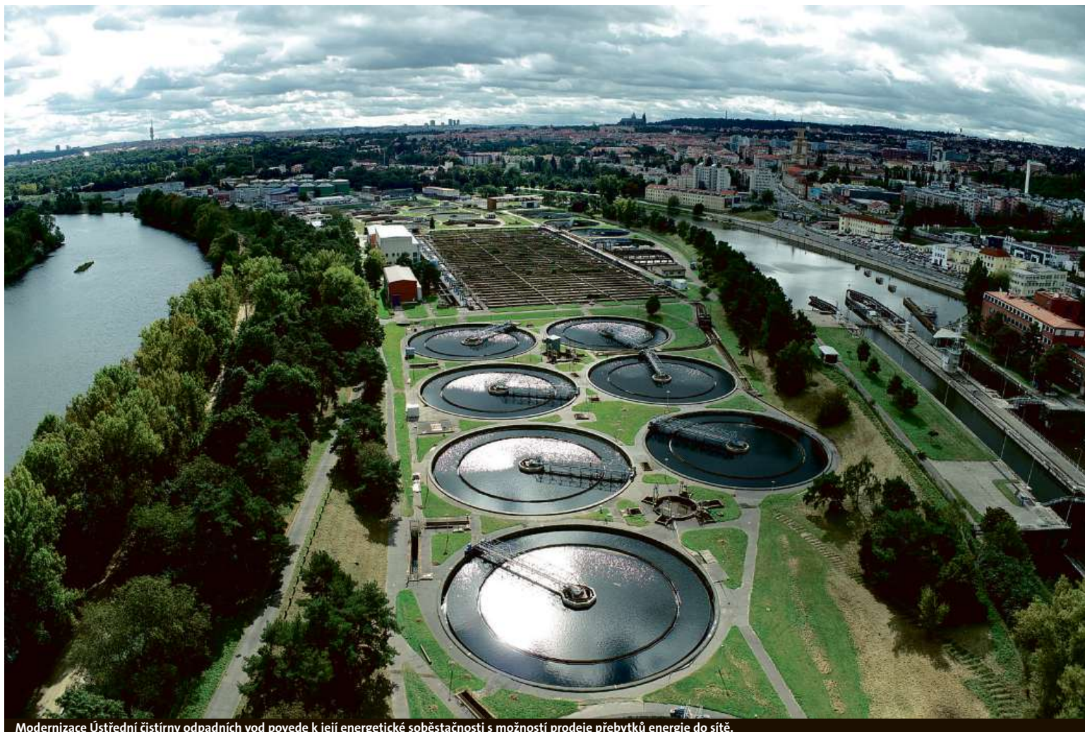
Modernizace Ústřední čistírny odpadních vod povede k její energetické soběstačnosti s možností prodeje přebytků energie do sítě.
